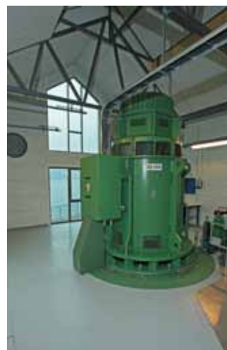
Maskinhallen i Dyrkorn kraftverk.
