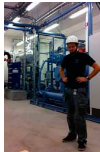
Tafjord Elektros medarbeider på jobb ved Valldal Fjernvarme.
