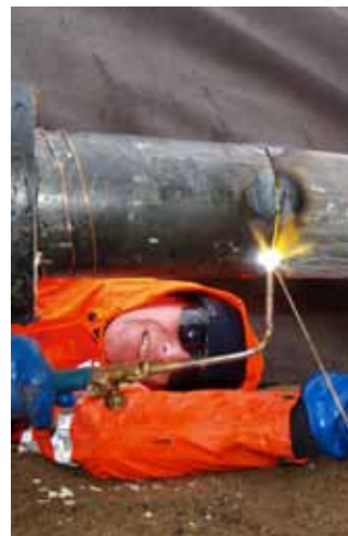
Sammensveising av muffe.
