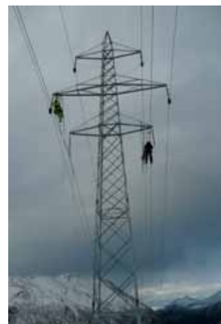
Den nye 132 kV linjen Valldal-Stordal ble satt i drift i mars 2011.
