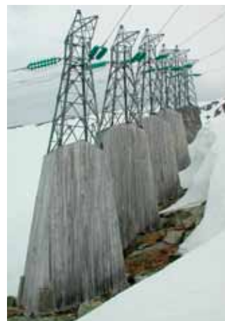
Forsøket med å kle inn mastefestet med treverk var vellykket. Snøen la seg ikke lenger inn til masten.
