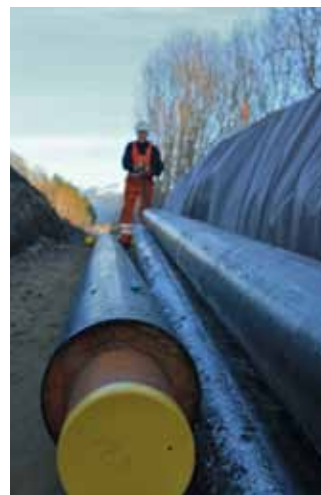
Fra den nye rørgaten i Holen.
