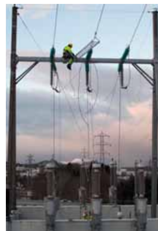
Arbeid på 132 kV linjen i Holen like før jul 2011.
