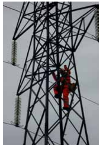
Drift og vedlikehold av nettet er en vesentlig del av arbeidsdagen for våre montører.
