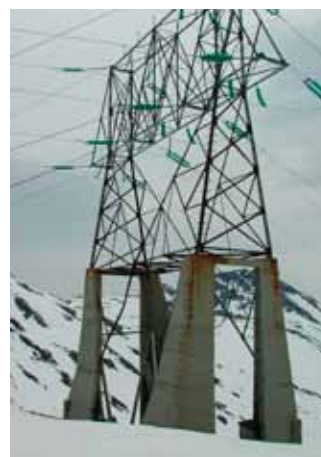
Problemet med snøsig var også bakgrunnen for at de store spennmastene på Svarhammaren og i Uriskaret fikk 12 m høye betongfundament tidlig på 70-tallet.
