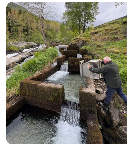
Stiftelsen Anadrom installerer videoovervåking av laks i laksetrappa ved Stadheimfossen i Korsbrekkeelva.
